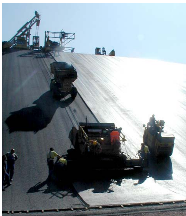
Abbildung 1.1: Winde (oben), Beschicker (mitte) sowie Fertiger und Walze (unten) beim Asphaltieren eines Wasserrückhaltebeckens
