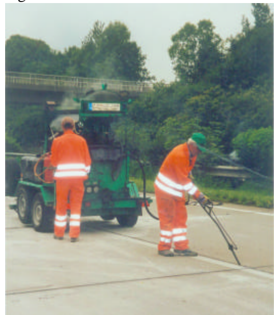
Kesselmann und Gießer beim Fugenverguss
